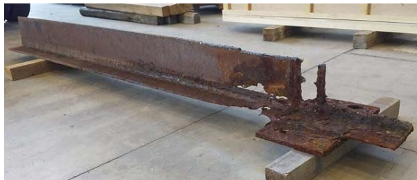
腐食劣化した鋼桁
