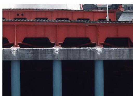
パイルベント基礎形式の昭和大橋の新潟地震での被害状況
