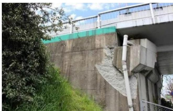
橋台端部のずれ(地震)
