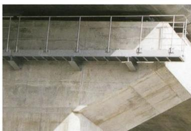
図 7.3 橋台、橋脚の支承周りへの検査路設置イメージ
