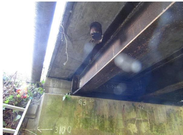
凍結防止剤散布による塩化物を含む排水により腐食
