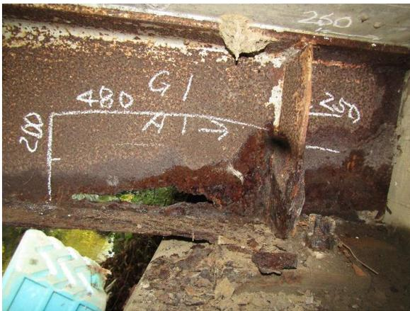
凍結防止剤散布による塩化物を含む排水が桁にかかり腐食
