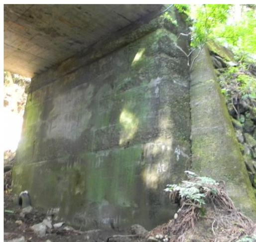
橋台の変位・凍害による土砂化
