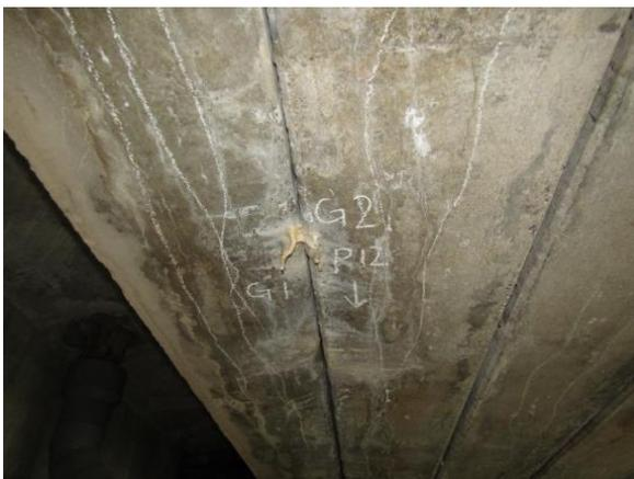
アルカリシリカ反応による橋軸方向のひび割れ
