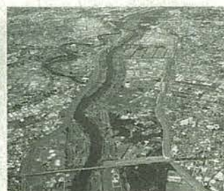
荒川第二・三調節池。事業実施区域と周辺。手前が羽根倉橋(下流側から)
